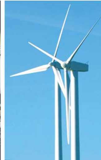
Dieselmootorit ja tuulivoima
